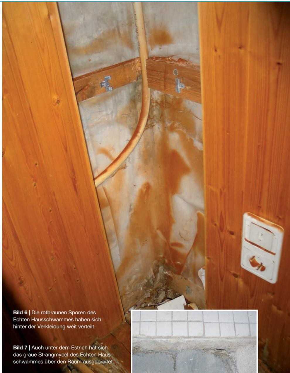
**Bild 6** | Die rotbraunen Sporen des Echten Hausschwammes haben sich hinter der Verkleidung weit verteilt.
