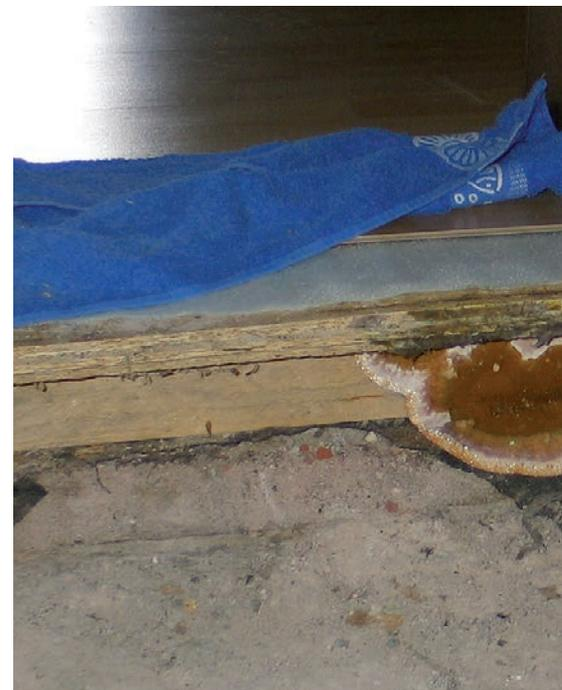
**Bild 4** | Fächerförmige Mycelstrukturen des Muschelkrepplings und Würfelbruch am bereits abgetrockneten Holz
