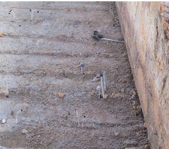
**Bild 1** | Befall durch Tintlinge an einer frei gelegten Holzbalkendecke
