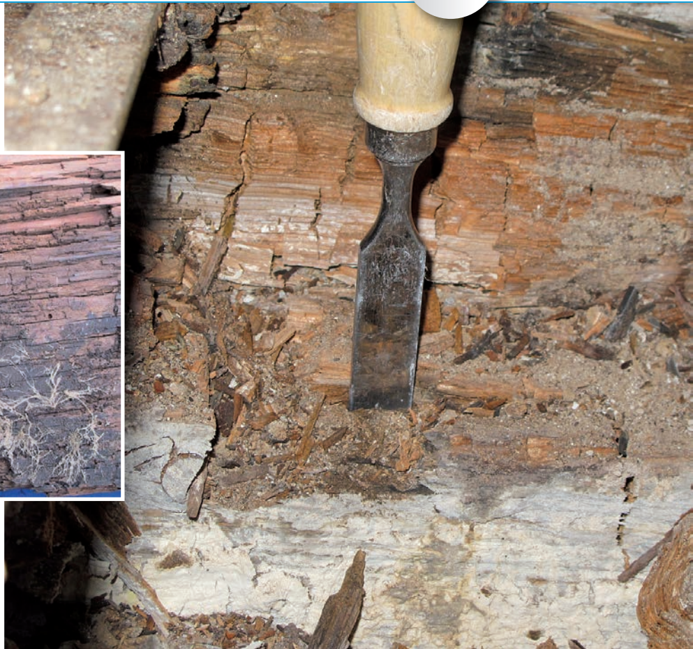
Bild 5 | Das Werkzeug kann in das vom Echten Hausschwamm geschädigte Holz mühelos eindringen.
