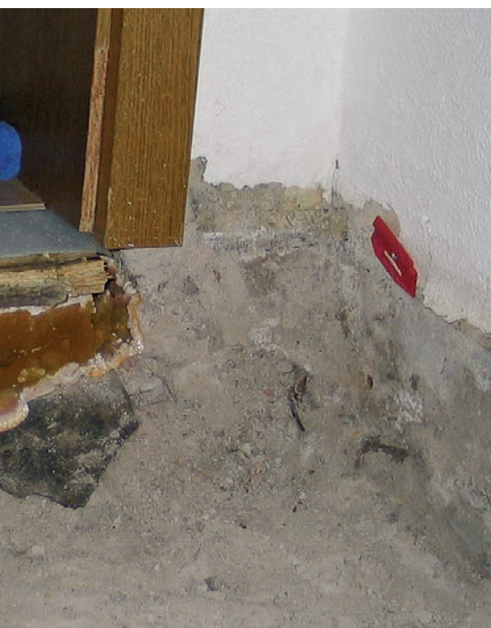
Bild 3 | Typischer Fruchtkörper des Echten Hausschwammes. Auch unter dem angrenzenden Fußboden kam es zu massiven Schäden am Holz.
